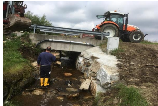
Brückensanierung in Eck
